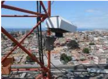
Optischer Richtfunk, genannt auch Laserlink, optische Freiraumübertragung, Freiraumkommunikation, (Laser-Übertragung, ist eine Technologie, die Daten direkt durch die freie Atmosphäre übermittelt. Dabei dient der unsichtbare Infrarotlichtstrahl (IR) als Träger, mit dem sich bis zu 4,4 Kilometer, abhängig von der klimatischen Bedingungen, übertragen lässt. Die optischen Richtfunksysteme haben eine extrem hohe Abhörsicherheit, weil der Strahlengang unsichtbar (infrarot) ist und scharf gebündelt.
